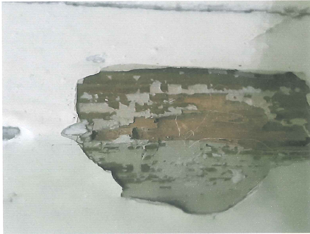
Fot. 15. Ołtarz boczny pw. Świętej Rodziny z kościoła pw. św. Stanisława Biskupa i Męczennika w Modliborzycach, woj. lubelskie. Stan październik 2023. Ubytek na pilastrze ukazujący odfionięte kanały świadczące o bytowaniu drewnojadów.
