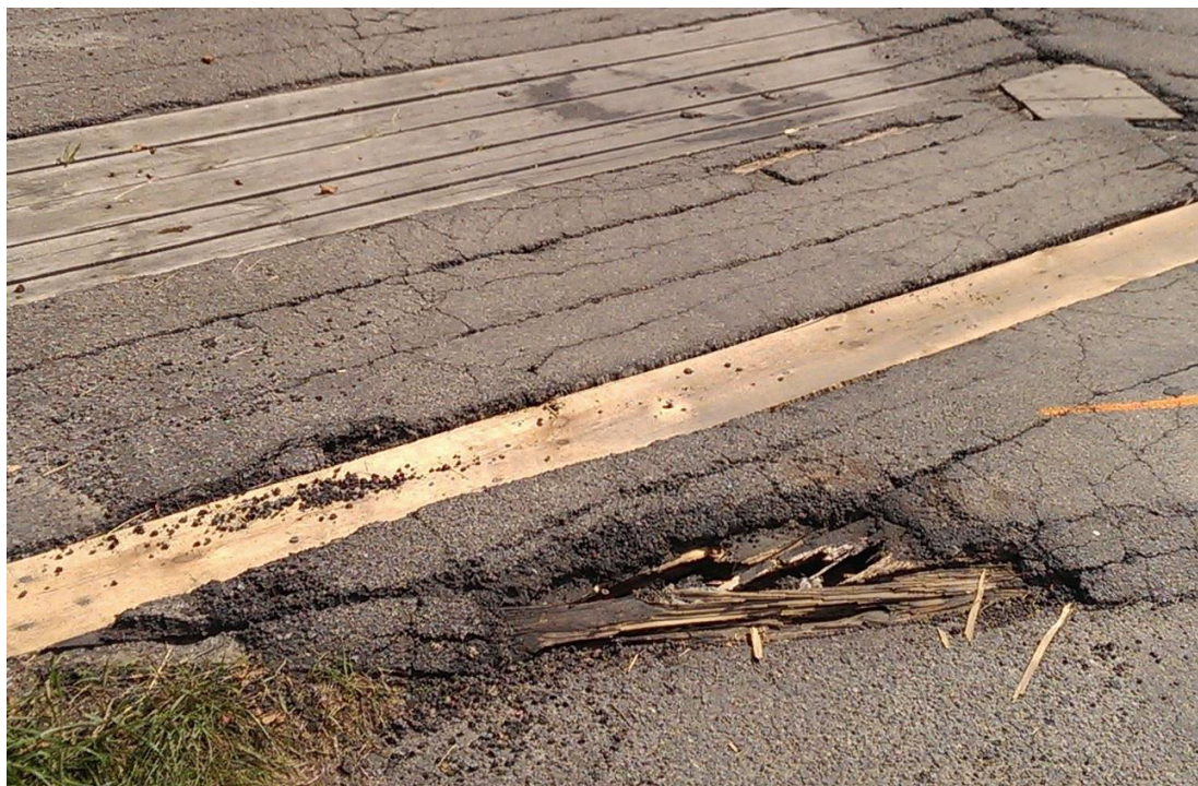
Uszkodzenia płyty pomostu
