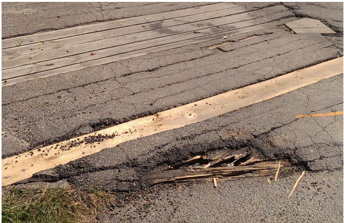
Uszkodzenia płyty pomostu
